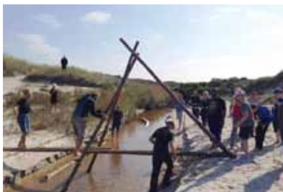
Construyendo un puente
